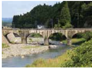
4連の宮ヶ原橋
