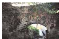
④㉕ 梅ヶ谷の眼鏡橋【八女】 ※平成24年水害により流失
