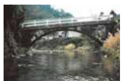
⑨ 八重谷橋【上陽】
